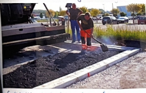
Schleith legt hier den Asphalt für eine neue Straße
